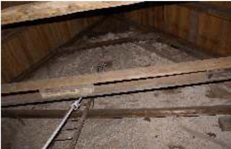
Der früher flachere romanische Dachverlauf des Kirchenschiffes ist an Ost- und Westgiebel noch gut zu erkennen. Spätere Umbauten erfolgten nach dem neueren spätgotischen Baustil etwas steiler. Viele originale Balken aus der Entstehungszeit des Kirchenschiffes sind noch im Dachstuhl erhalten, sowie auch im Turmdachstuhl.
