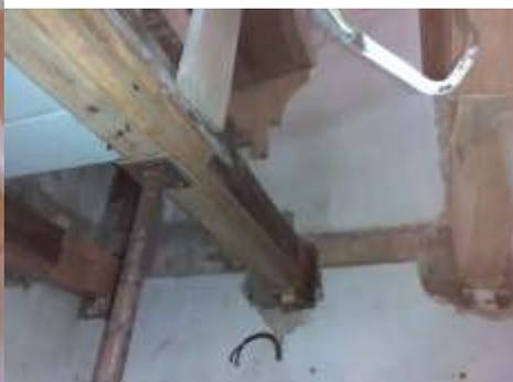
Die stark verrotteten Balkenstümpfe an der Nord- (rechts) und Südempore (links) wurden 2023 entfernt sowie neue "angeschuh". Dabei entdeckte Herr Körner an der Nordempore auch das weiter vorn bereits erwähnte und abgebildete Tischlerbrett von Theodor Frommherz von 1861.
